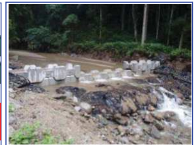
②溪流保全工
