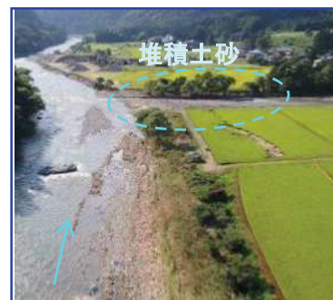
① iii) 本川合流箇所の土砂堆積
