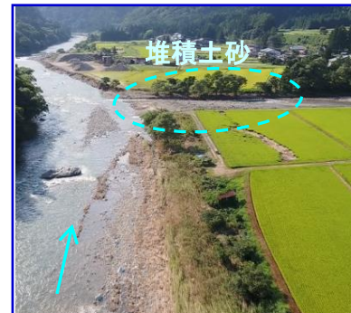
① iii)本川合流箇所の土砂堆積
