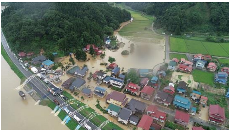
平成30年8月の大雨に係る被害状況（戸沢村）
