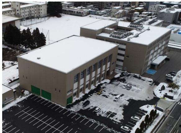
H30完成の 山形工業の体育館
