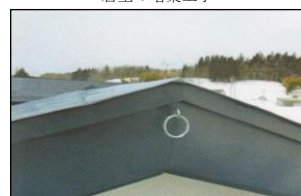
【克雪化リフォームの例】 雪下ろし用命綱を固定する金具の取付け
