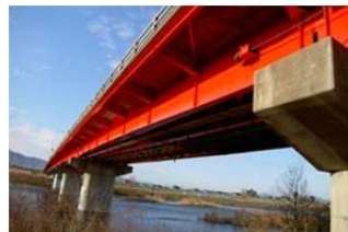
再塗装により長寿命化
