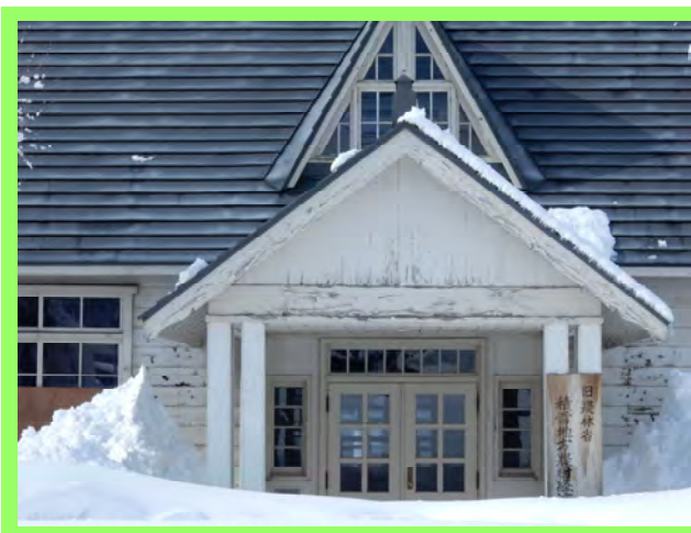
雪の里情報館の一部として現存する旧農林省積雪地方農村経済調査所の建造物。
