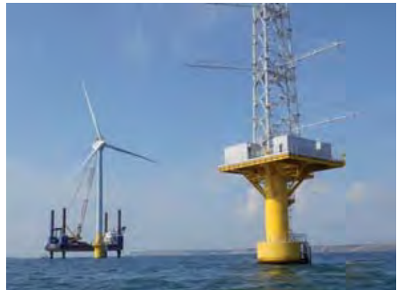
NEDO（銚子沖）左：洋上風車、右：洋上風況観測タワー
