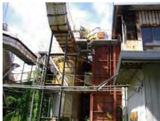
廃止後未解体となっている焼却施設
