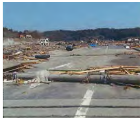
大地震(津波)による道路の被災
