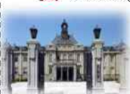
国指定重要文化財 山形県郷土館「文翔館」
