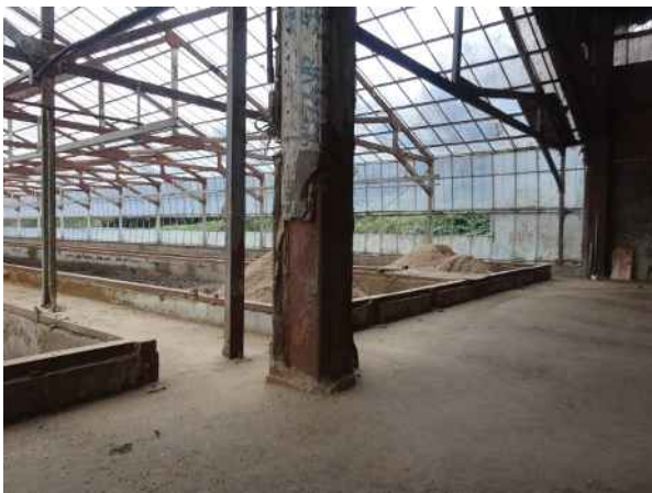
腐食が進んだ鉄骨の柱（左側）と攪拌機（右側）
