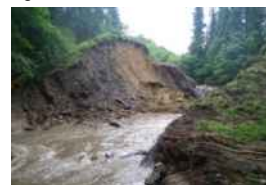
決壊したため池
