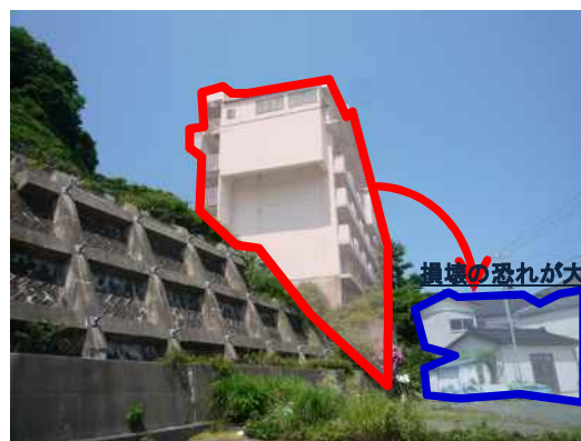
※民家が近接している状況
