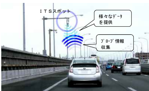
図2. ITSスポットでの情報提供・収集 (国土交通省HPより転写)
