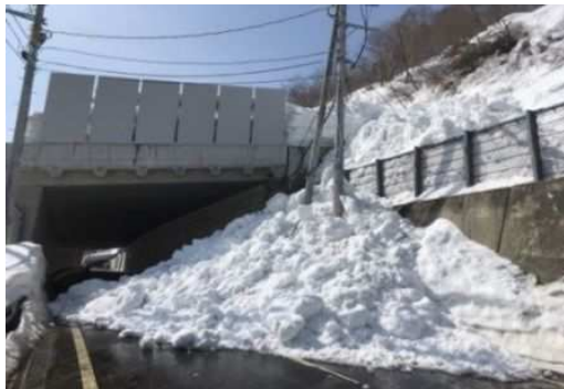
米沢飯豊線・雪崩発生状況 (平成30年3月、片側通行止め3週間)
