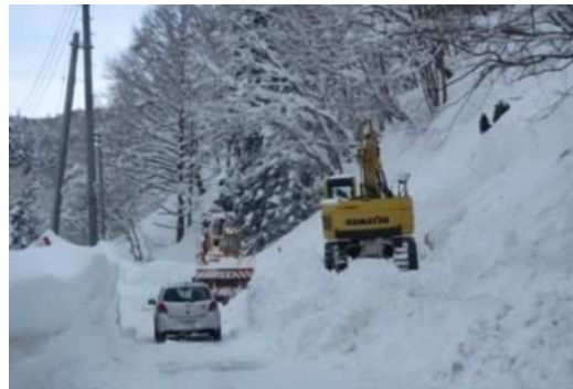
尾花沢最上線・雪底処理状況 (平成30年2月、片側通行止め3日間)
