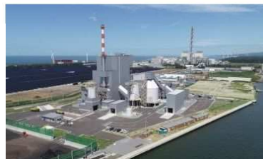
バイオマス発電所の立地 (酒田臨海工業団地 H30.8 稼働)
