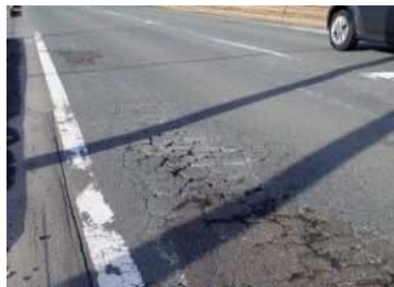
舗装の損傷状況
