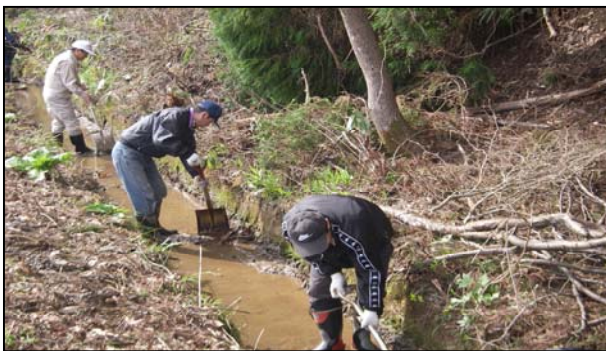
多面的機能支払制度の農地維持支払で取組む水路の泥上げ状況
