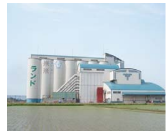
県内庄内地方のカントリーエレベーター
