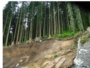
集中豪雨に至らない短時間の強い雨で崩壊した道路法面 (鶴岡市H27.5.5)
