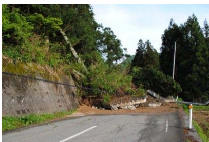
集中豪雨に至らない短時間の強い雨で崩壊した道路法面 (鶴岡市H27.5.5)
