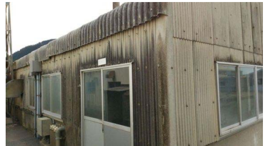
老朽化が進み雨漏りが発生するなど、多くの修繕が必要な山形県栽培漁業センター
