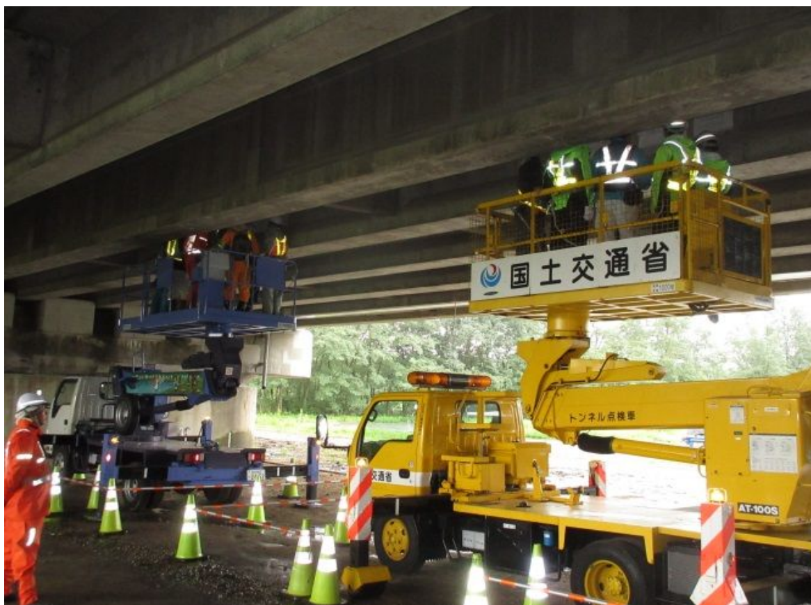
現場見学会(橋梁等補修工事)の様子
