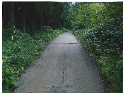
（林道田沢線修繕後の状況）
