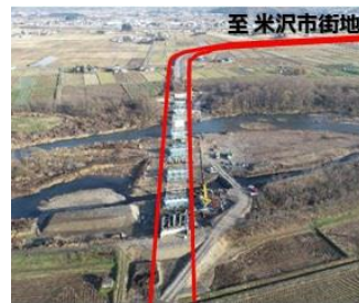
③国道287号（米沢長井道路）
