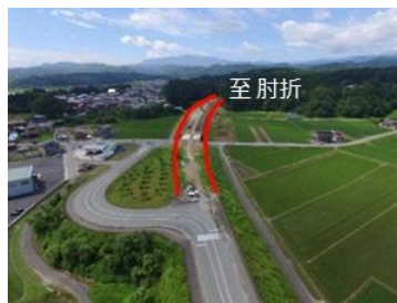
②国道458号（本合海バイパス）
