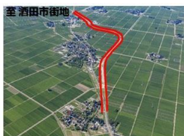
①国道344号（安田バイパス）
