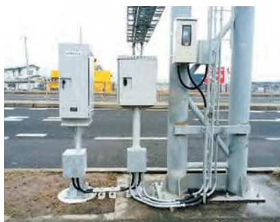
山形管内経路情報設備用電源設置工事
