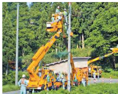
東北電力管内配電線工事
