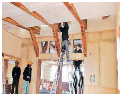
屋内配線工事
