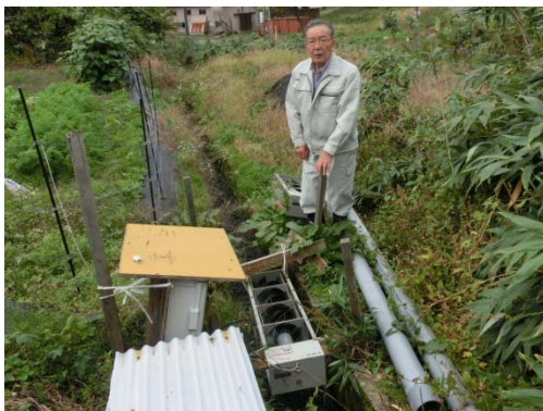
当初設置した水車（水路上部）。増水により2度流されたことがある。
