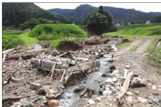
左写真のため池の隣にある沢で、氾らんにより道路、橋、水路などが大きな被害を受けた
