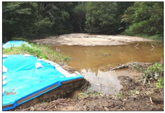
ため池が土石流を防ぐ砂防ダム役割を果たし下流の田畑や民家の被害を軽減させた
