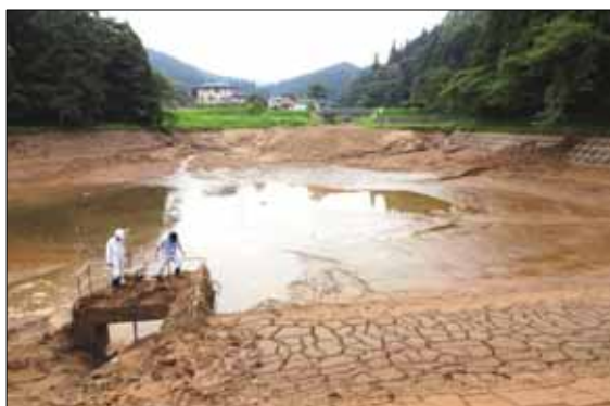
豪雨により流入した水を一時的にため込み下流域の氾らんを抑制させた(写真は堆積した土砂のようす)
