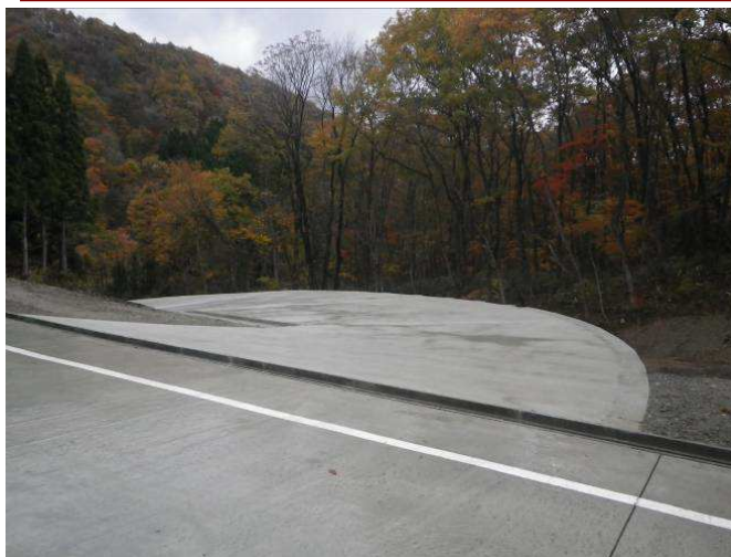
②工事用道路(上流)
