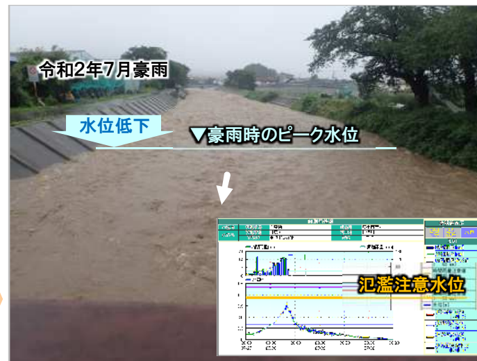
▲ 日塔川(東根市) 令和元年度実施 堆積土砂撤去 支障木・堆積土砂の撤去により出水時の水位が低下 氾濫注意水位を上回ることなく浸水被害軽減に効果を発揮
