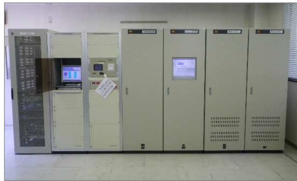
▲ 既設のダムコントロール設備
