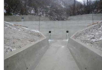
【治山: 溪間工(治山ダム)】
