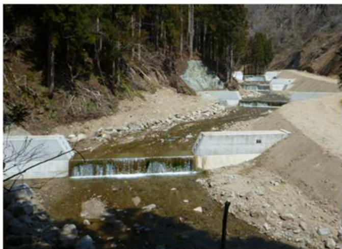
溪床の安定化を図る治山ダム
