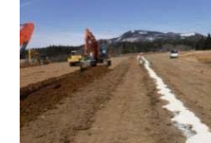
石礫除去及び珪藻土による保水性と通気性、排水性の向上
