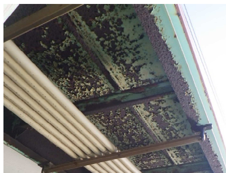
桁の損傷状況及び歩道下の腐食
