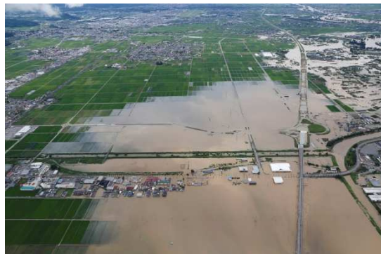
令和2年7月豪雨の浸水被害（村山市）
