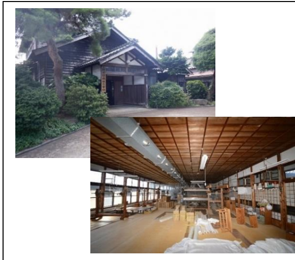
事務所及び仕立棟
