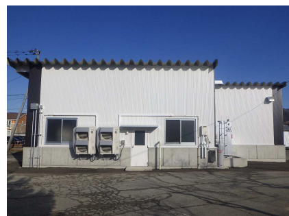
解剖棟(令和5年度完成)
