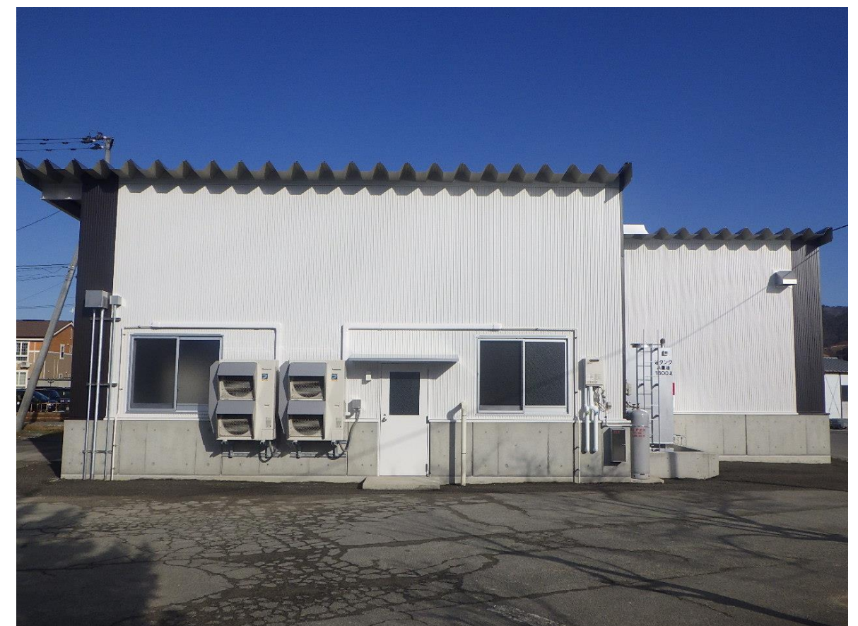
解剖棟(令和5年度完成)
