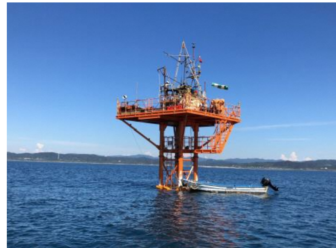
鋼製檣の設置状況図
