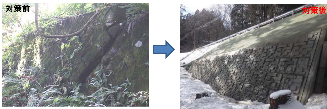
擁壁補修+上法面の植生を実施
