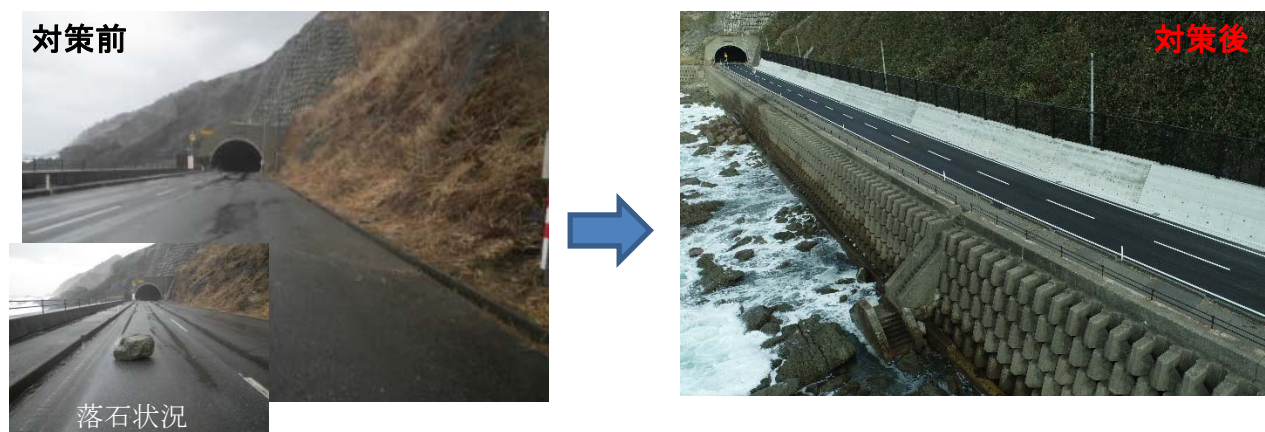
擁壁工+落石防護柵工を実施
