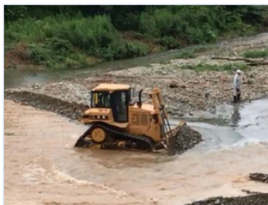
ブルドーザによる河床整正作業 (川底を均し、流下能力の維持を図る)
