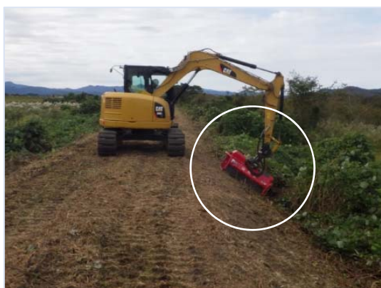
草刈り装置を取り付けたバックホウによる堤防除草作業
