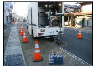
写真 管渠点検調査 (テレビカメラ調査)
