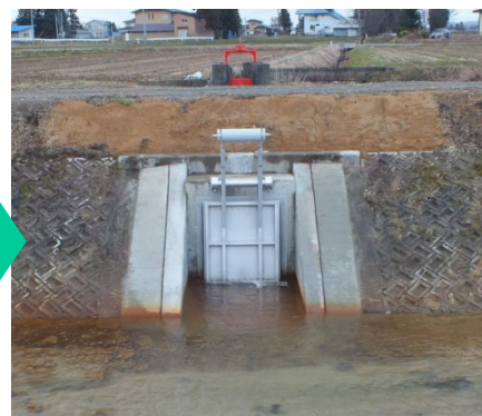
更新時のゲート操作の無動力化の推進（フラップゲート等）
