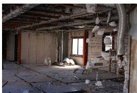
改修前（空きフロア）
