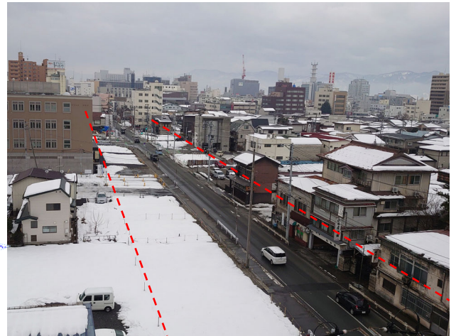
事業進捗状況（R3.1）北から南を望む
