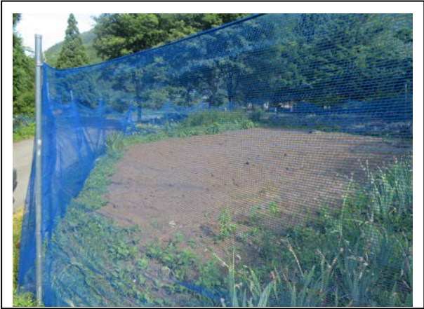
防護ネットの設置状況(関沢)
