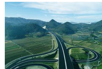
国道13号の代替・補完機能を果たす東北中央自動車道
