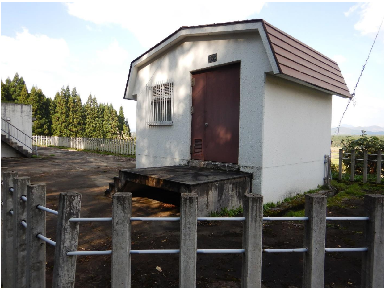
最上広域水道 真室川量水所
