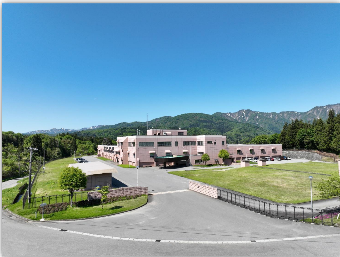
庄内広域水道 朝日浄水場
