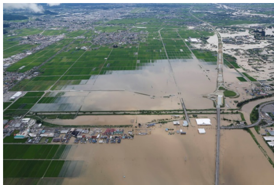
令和2年7月豪雨の浸水被害（村山市）
