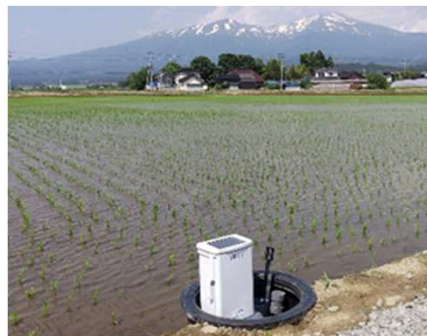
自動給水栓(遊佐町)
