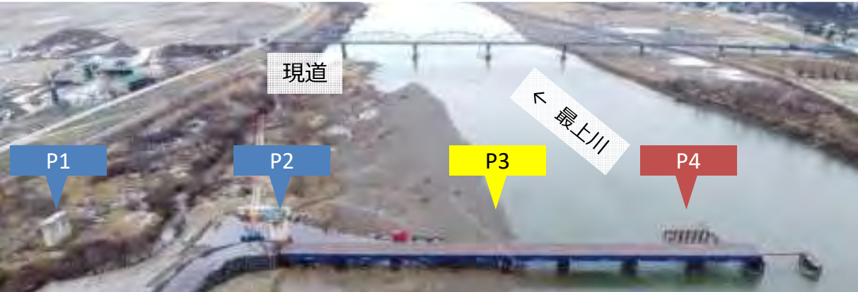
③仮栈橋(R2.3月撮影)
