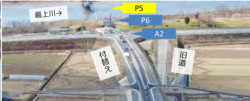
②国道345号改良箇所(R2.3月撮影)
