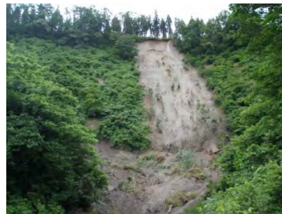
土砂崩落箇所(H23)
