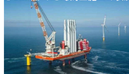
○SEP船※による海上施工の状況
