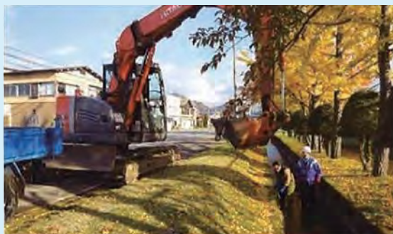
土砂上げの状況
