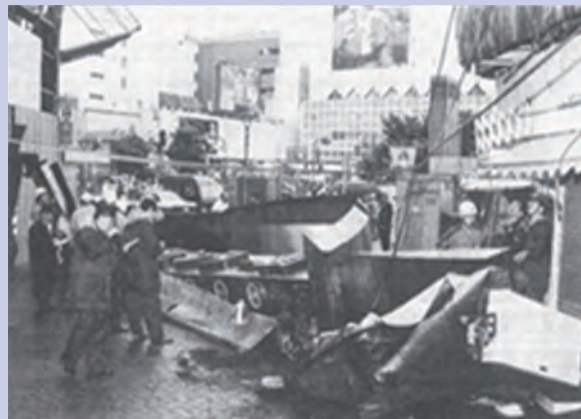
台風で落下した時の様子
