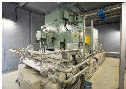
ボイラーにて発生した蒸気のでタービン発電機を動かし、電気エネルギーへと変換します。
