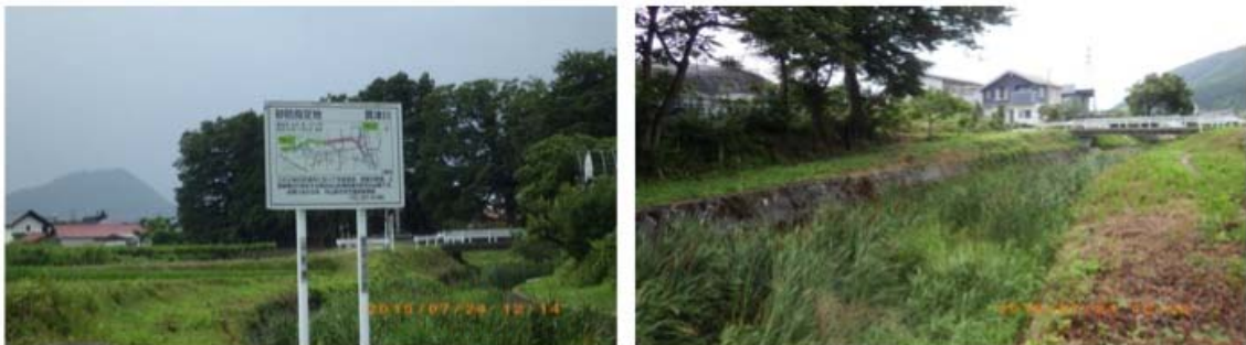
図4b 貫津川St 3付近の河床の様子
