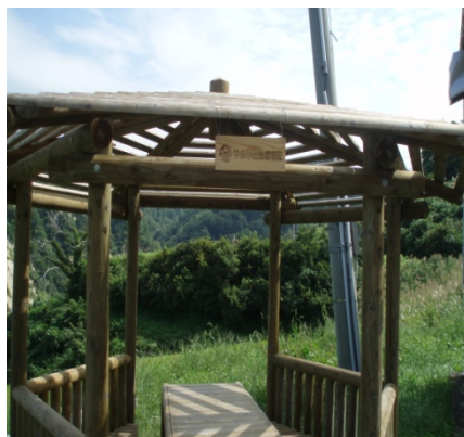
▲みどり環境税を活用した木製構造物に環境税のPR板を設置しました。 (大蔵村四ヶ村)
