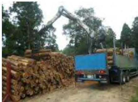
間伐材搬出状況（合板・集成材用）
