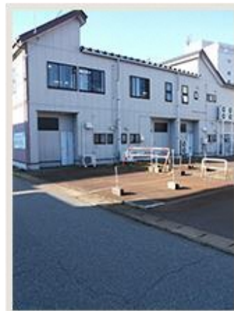
建物裏側 駐車場 (1台分)
