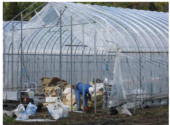
写真 48 ハウス骨材と被覆資材の補修作業の状況
