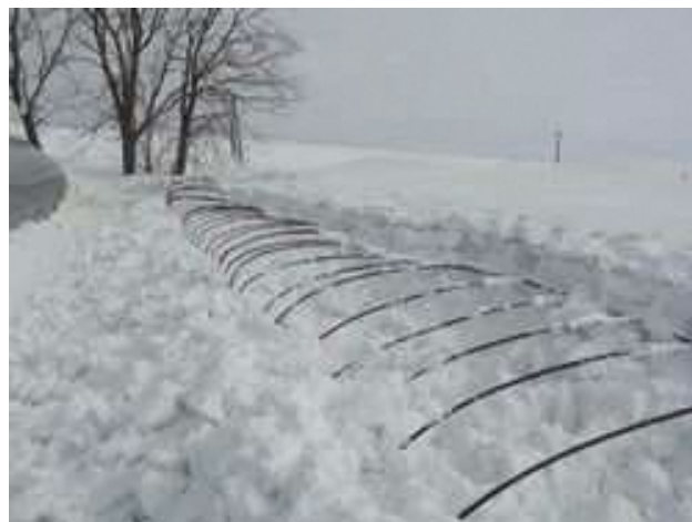
写真 51 雪に埋没したパイプハウスの掘上げ作業
