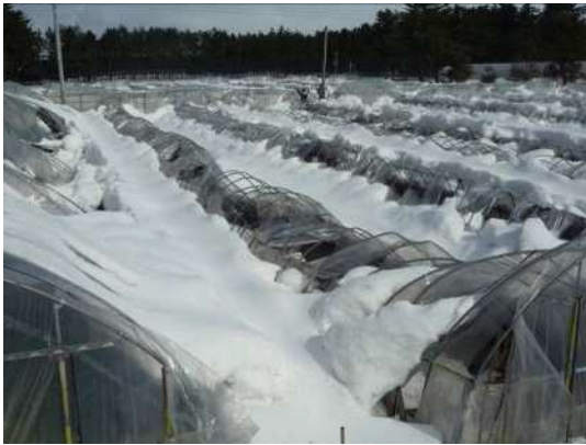
写真45 倒壊したハウスの状況 (外側)
