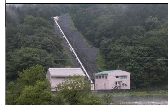
【参考事例】 蘇岡発電所 (発電所建物・水圧鉄管)
