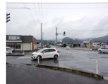
防護柵設置状況 (主) 上山七ヶ宿線[上山市]
