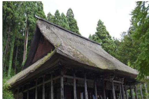
重要文化財 本山慈恩寺本堂
