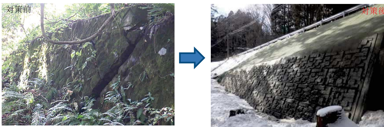
擁壁補修+上法面の植生を実施
