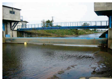
防錆対策の実施
