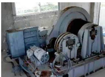
機械設備の補修の実施
