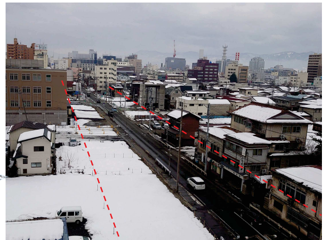
事業進捗状況 北から南を望む
