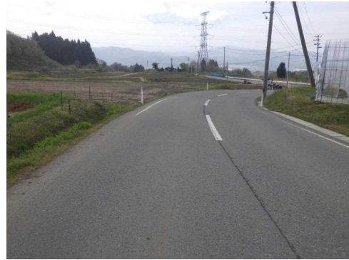
【Aから見た現場の状況】
