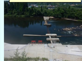
頭首工の整備例
