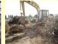
再生作業（障害物除去・深耕・整地等）
