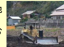
再生作業（障害物除去・深耕・整地等）
