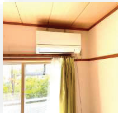
エアコン設置
