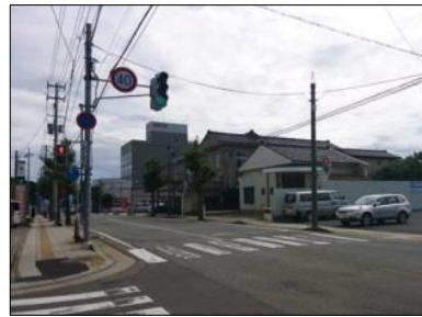
▲電線が立ち並ぶ状況(②)
