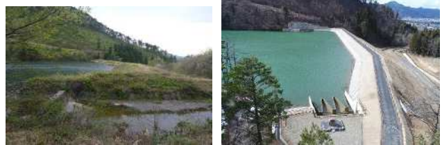
松沢ため池（上市市）対策前
