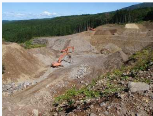
< 遊佐町の採石現場の状況 >
