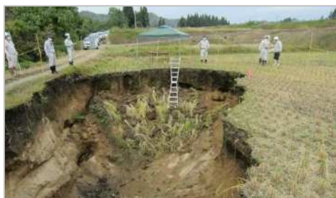
< 令和2年発生 舟形町の大規模な陥没 >
