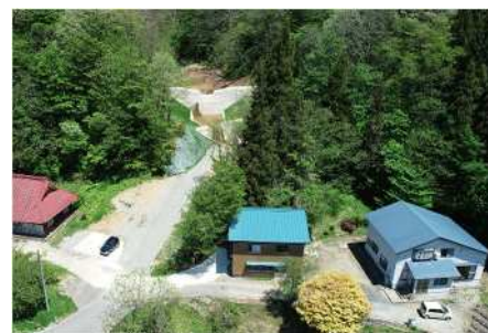
平成30年8月豪雨災害の復旧状況（戸沢村の治山ダム）
