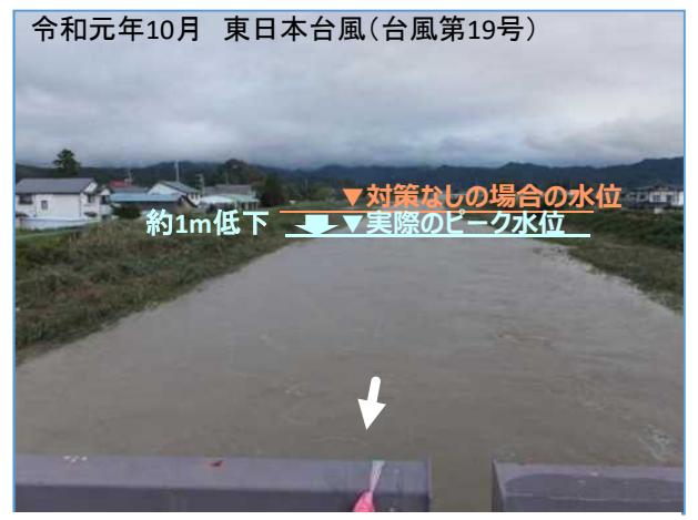
▲屋代川(高島町)平成30年度実施 堆積土砂撤去
