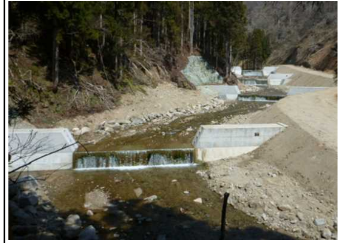
溪床の安定化を図る治山ダム
